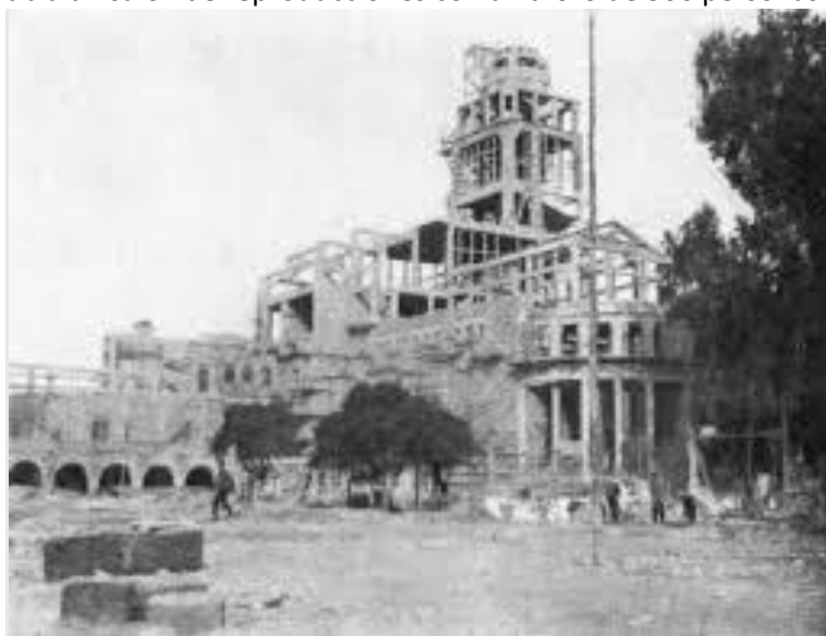
El Pabellón de Chile en obras
